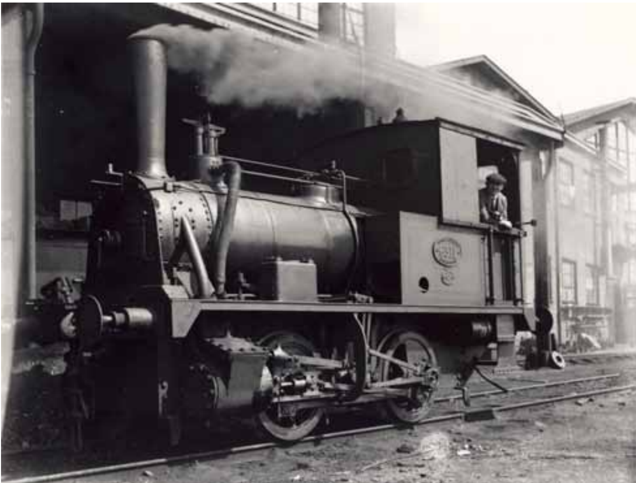
Zandstrooi-installatie boven voorwiel op voetenplaat
