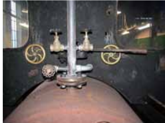
Proefplaatsing conform origineel van afsluiters
