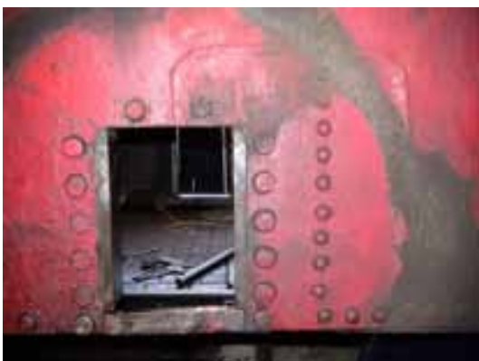
Scheurvorming scheenpoort rechts
