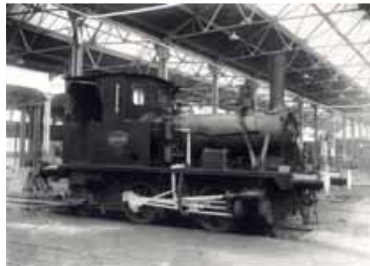
Plaatsing luchtpomp op locomotief type 6500
